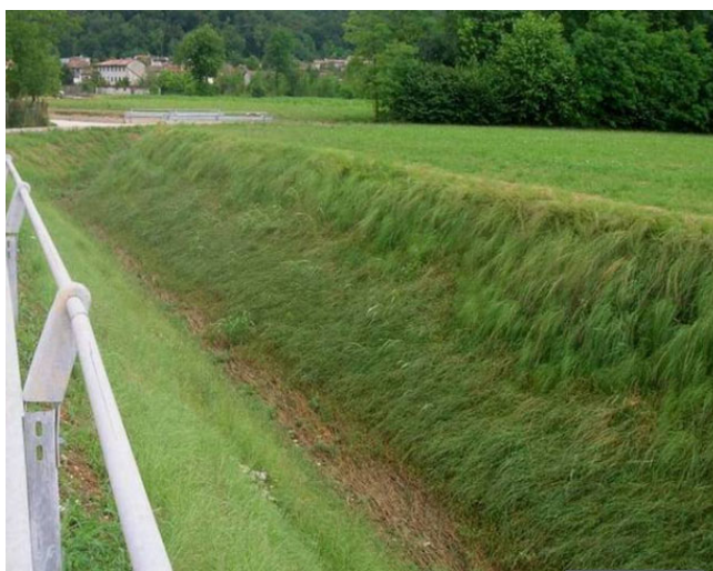
Figura 5.7 Esempio di applicazioni analoghe: canale con sponde rivestite da prati armati.
